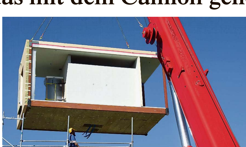
Die Küche wird als eines von sieben Modulen in den Baukörper eingefügt.
